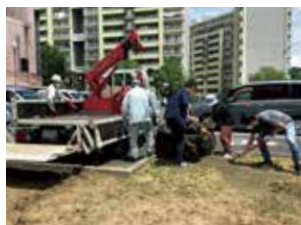
浄水発生土の搬入
